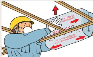
付属防湿フィルムが室内側になるようにU字に折り曲げたものを充填します。
