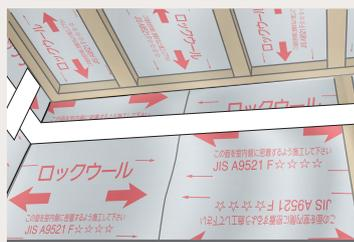
防湿気密シートの継ぎ目部分に気密テープを張り付けます。
