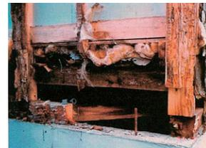
内部結露により躯体が腐朽
