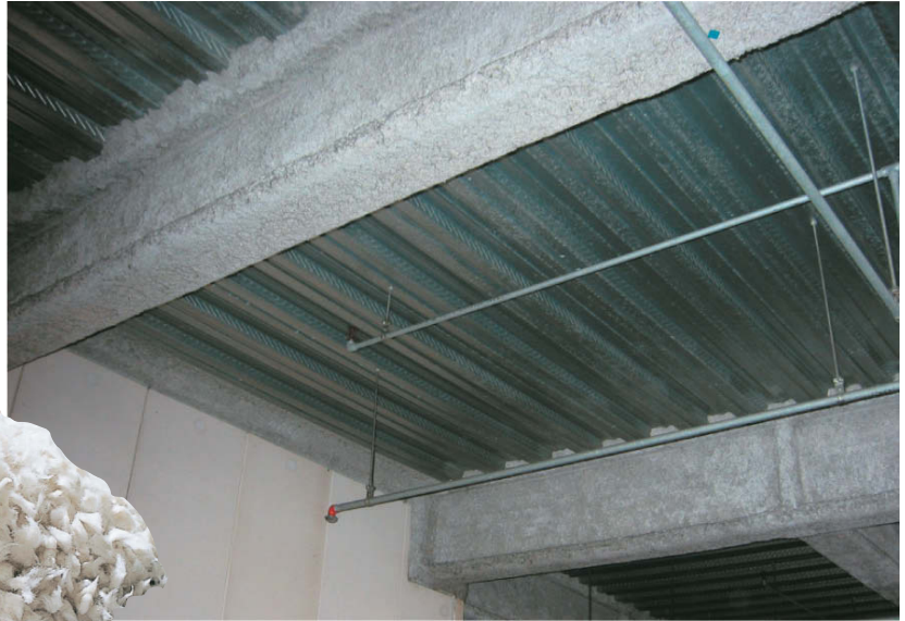
鉄骨耐火被覆施工例
