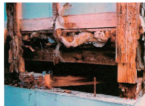
内部結露により躯体が腐朽
