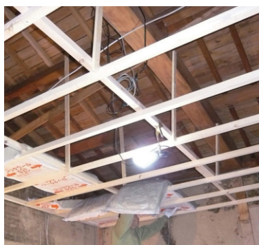
野縁を新しく施工します
