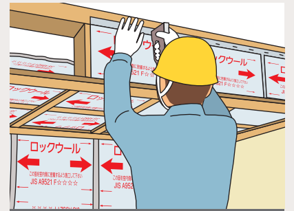
下がり壁施工中
