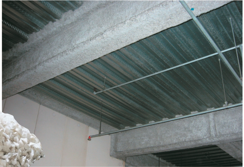
鉄骨耐火被覆施工例
