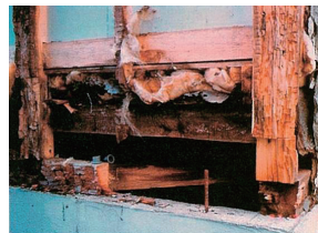
内部結露により躯体が腐朽
