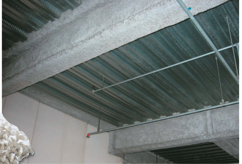
鉄骨耐火被覆施工例
