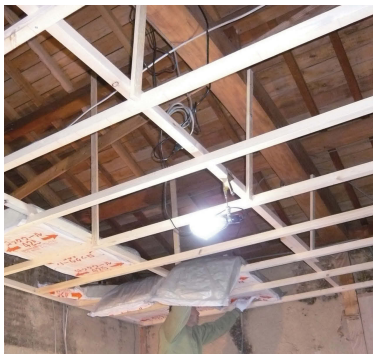
野縁を新しく施工します
