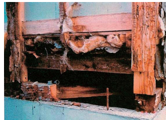
内部結露により躯体が腐朽
