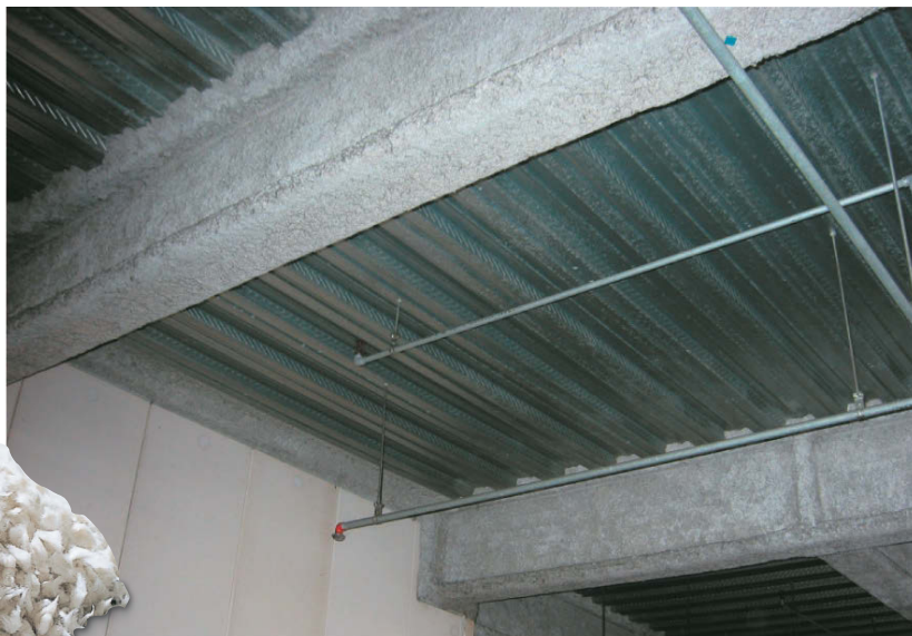
鉄骨耐火被覆施工例
