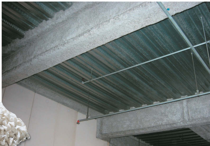
鉄骨耐火被覆施工例
