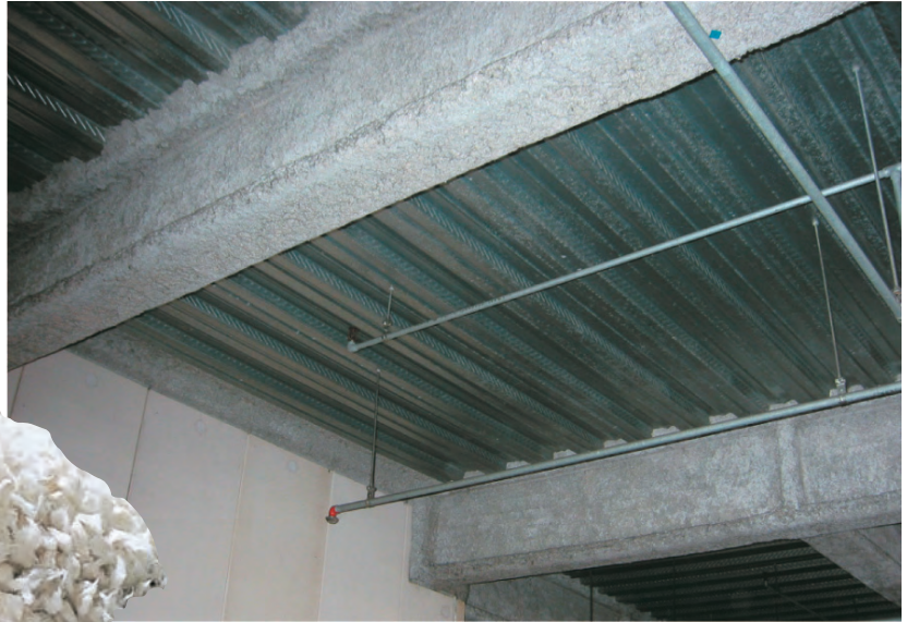
鉄骨耐火被覆施工例
