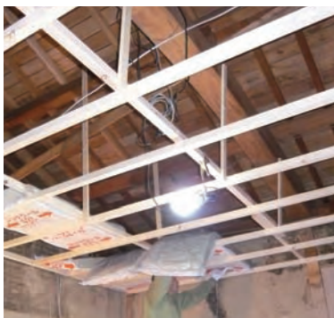
野縁を新しく施工します
