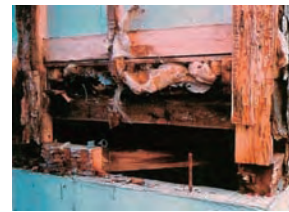
内部結露により躯体が腐朽
