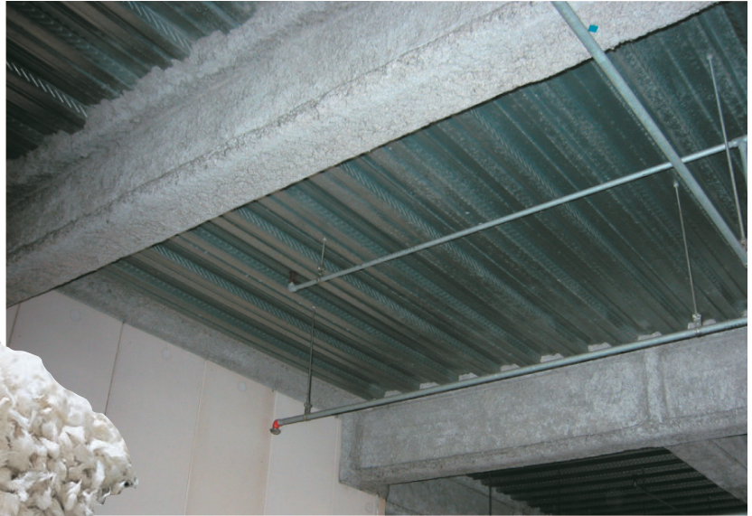
鉄骨耐火被覆施工例
