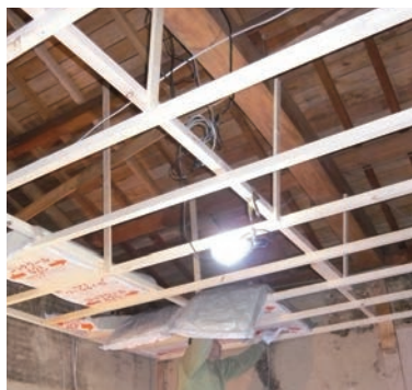
野縁を新しく施工します
