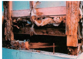
内部結露により躯体が腐朽
