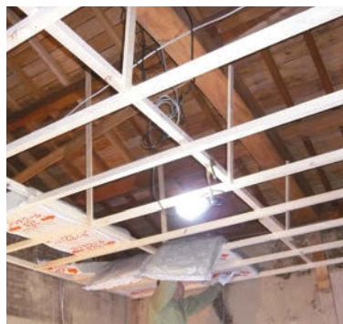
野縁を新しく施工します
