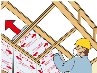
野縁上にアムマット施工中
