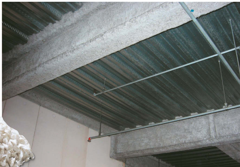
鉄骨耐火被覆施工例
