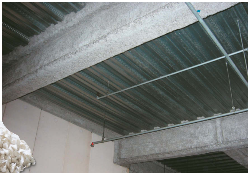
鉄骨耐火被覆施工例
