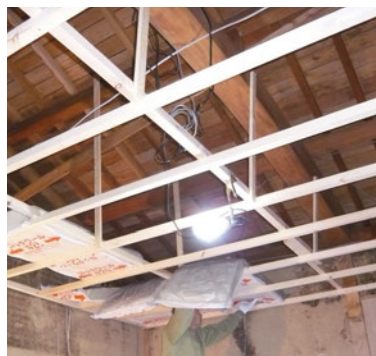
野縁を新しく施工します
