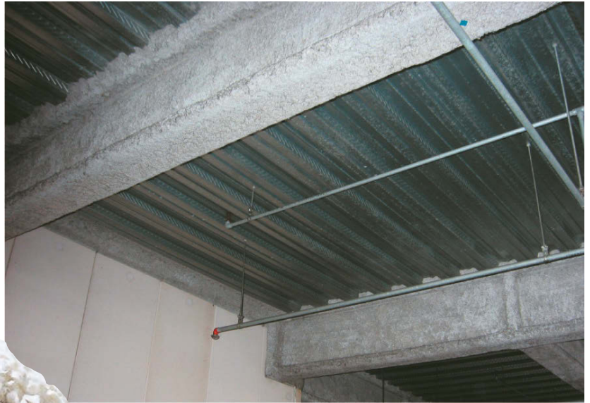
鉄骨耐火被覆施工例
