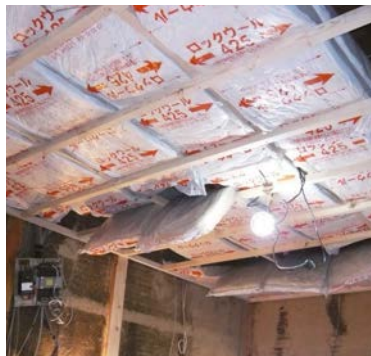
ロックウールマットを敷き詰めます
