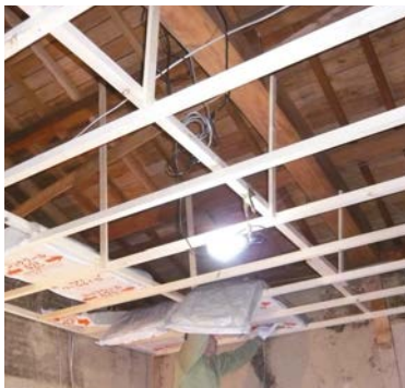
野縁を新しく施工します
