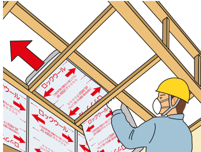
野縁上にアムマット施工中
