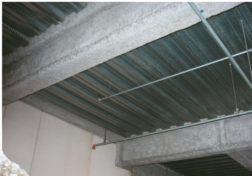
鉄骨耐火被覆施工例
