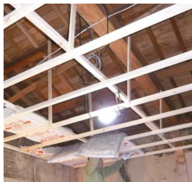
野縁を新しく施工します
