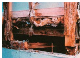
内部結露により躯体が腐朽
